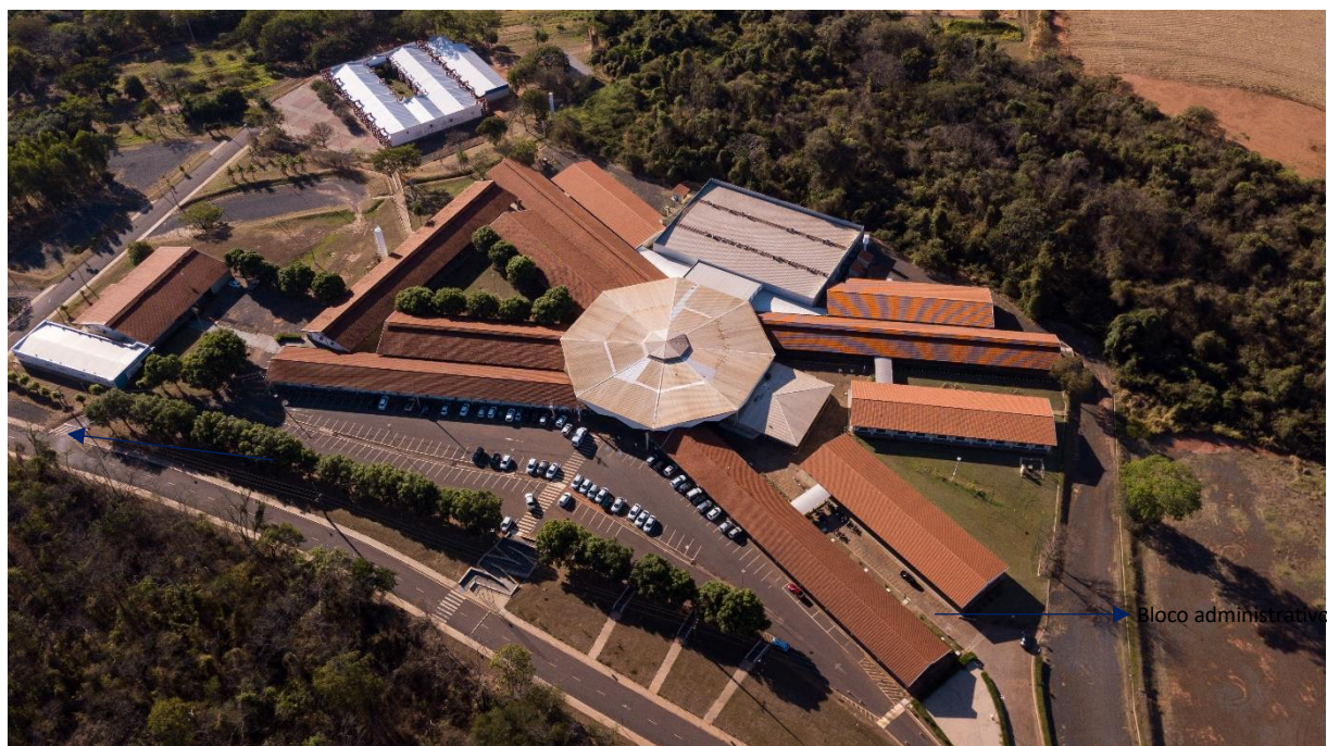
Figura 2 - Vista aérea - Pátio Central
